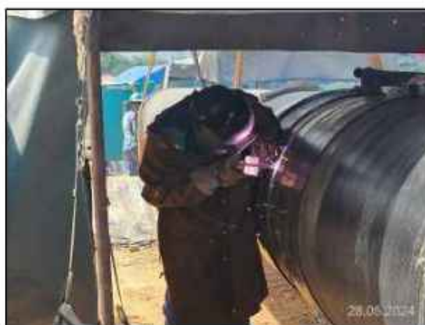
ข) การสวมใส่อุปกรณ์ป้องกันอันตรายของผู้ปฏิบัติงานเชื่อมท่อ
