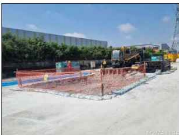
รูปที่ 2-15 การติดตั้ง Sheet pile ป้องกันการพังทลายของดินบริเวณบ่อรับ-บ่อส่ง
