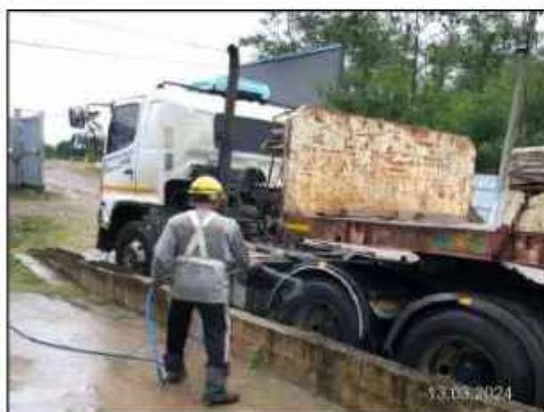
รูปที่ 2-9 การจัดทำพื้นที่ล้างล้อทำความสะอาดเศษดินและเศษโคลนที่ติดกับล้อรถ
