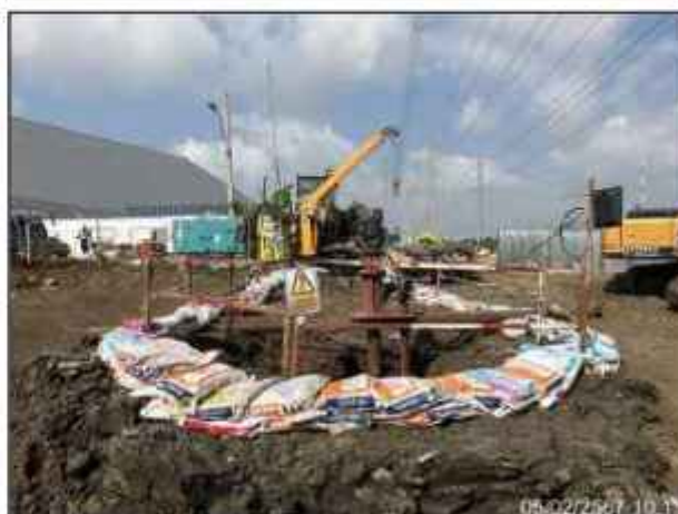
รูปที่ 2-16 การวางถุงทรายหรือจัดทำคันดินกันรอบพื้นที่บ่อรับ- บ่อส่ง
