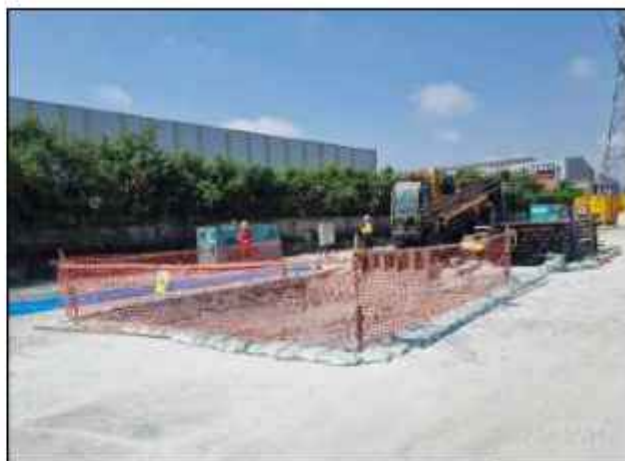
ก) การจัดวางถุงทรายหรือจัดทำคันดินกันโดยรอบบ่อรับ-บ่อส่ง
