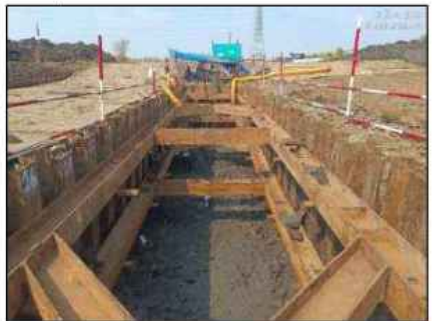
จ) การติดตั้ง Sheet Pile ป้องกันดินถล่ม
