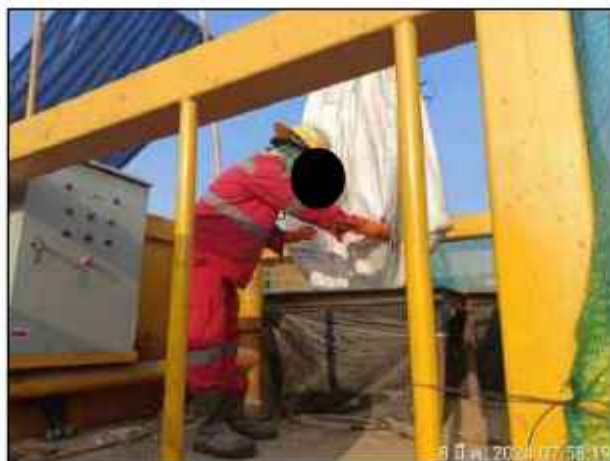
ฉ) การผสมโซเดียมเบนโทไนต์เพื่อใช้ในการเจาะลุด ให้พอดีกับปริมาณงานเจาะลุด
