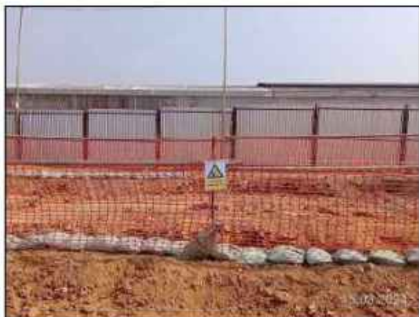
ก) การจัดวางถุงทรายหรือจัดทำคันดินกันโดยรอบบ่อรับ-บ่อส่ง
