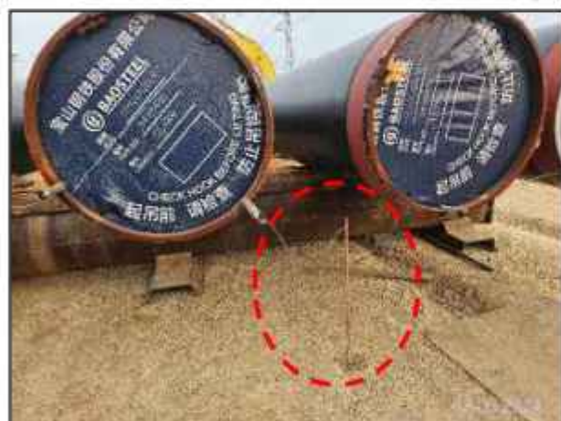
ค) การต่อสายดินกับท่อที่วางเรียงได้ส่งไฟฟ้าแรงสูง โดยใช้ปากคียบบริเวณที่จับ (Clamp) กับท่อส่งก๊าซธรรมชาติ
