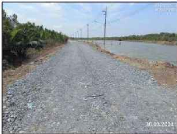
รูปที่ 2-17 การจัดทำทางชั่วคราว (Temporary Access Road)
