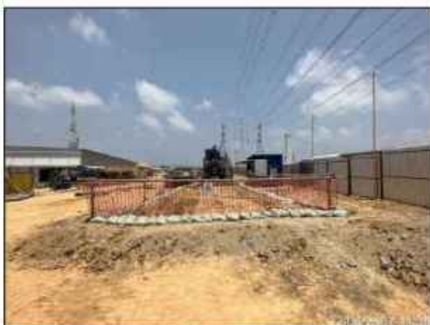
รูปที่ 2-16 การวางถุงทรายหรือจัดทำคันดินกันรอบพื้นที่บ่อรับ- บ่อส่ง
