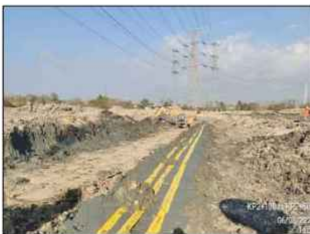
การวางแถบสีเหลือง (Warning Tape) ที่มีข้อความเตือน และฝังแผ่นคอนกรีตเหนือแนวท่อ
