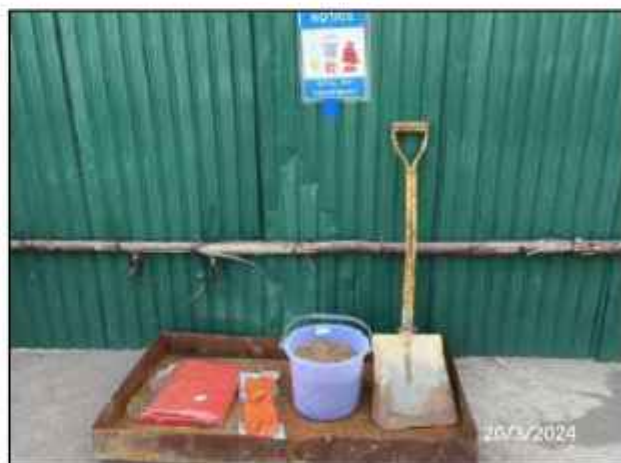
รูปที่ 2-25 จัดเตรียมภาชนะรองรับป้องกันการหกรั่วไหลของน้ำมันและสารเคมี พร้อมทั้งวัสดุดูดซับ
