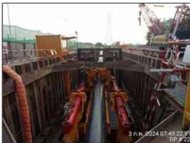
รูปที่ 2-15 การติดตั้ง Sheet pile ป้องกันการพังทลายของดินบริเวณบ่อรับ-บ่อส่ง
