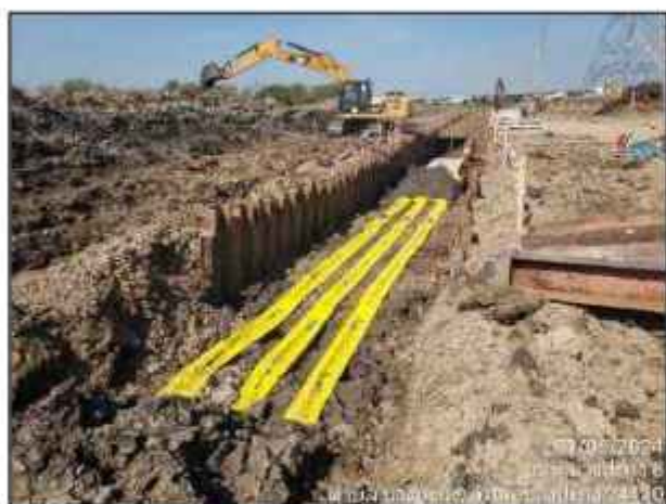
การวางแถบสีเหลือง (Warning Tape) ที่มีข้อความเตือน และฝังแผ่นคอนกรีตเหนือแนวท่อ
