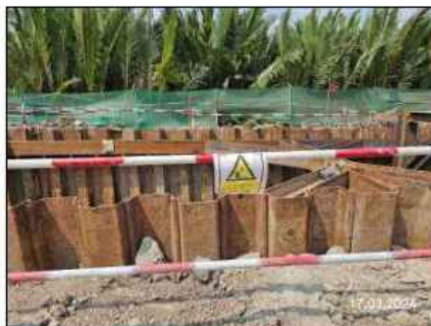
รูปที่ 2-15 การติดตั้ง Sheet pile ป้องกันการพังทลายของดินบริเวณบ่อรับ-บ่อส่ง
