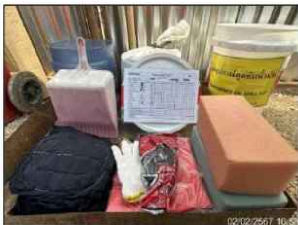
รูปที่ 2-25 จัดเตรียมภาชนะรองรับป้องกันการหกรั่วไหลของน้ำมันและสารเคมี พร้อมทั้งวัสดุดูดซับ
