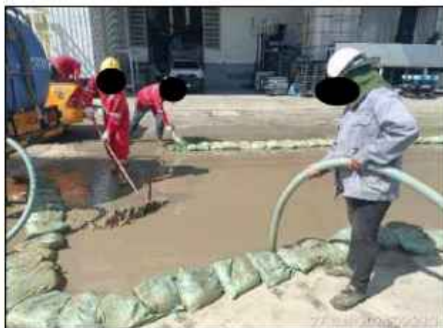
ค) การกั้นล้อมเขตพื้นที่ที่ได้รับผลกระทบโดยใช้กระสอบทรายปิดกั้นพื้นที่
